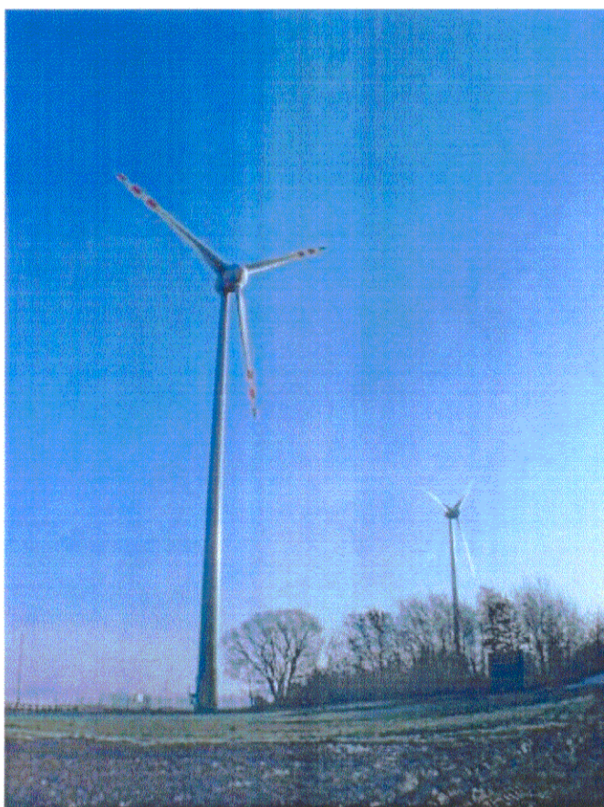
Elektrownie wiatrowe E-48 i E-53 w Wysocku Wielkim koło Ostrowa Wielkopolskiego
