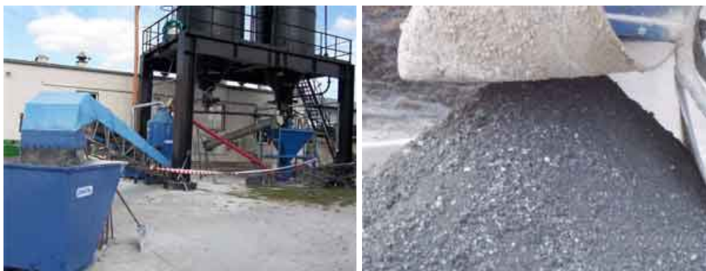
Rys. 2 Wygląd instalacji FuelCal oraz gotowego produktu
