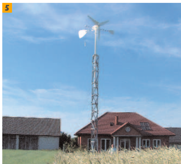
Fot.: MAST (montaż)
